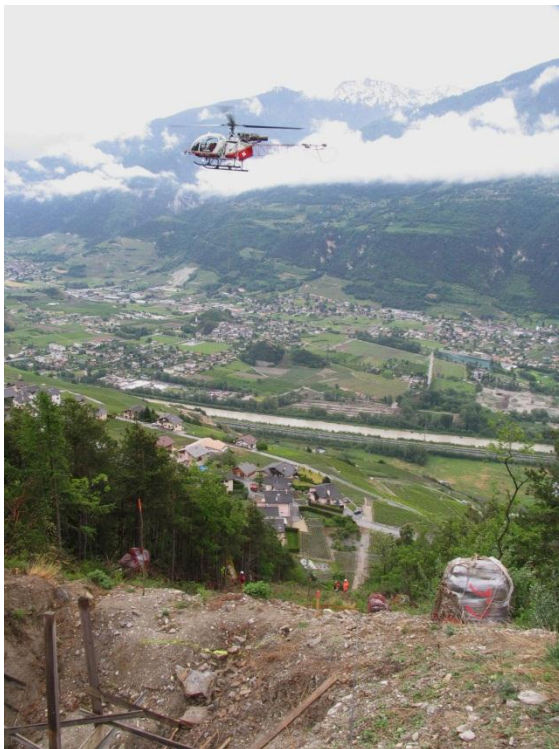
Abb. 8: Materialtransport mittels Helikopter Quelle: Helbling AG
