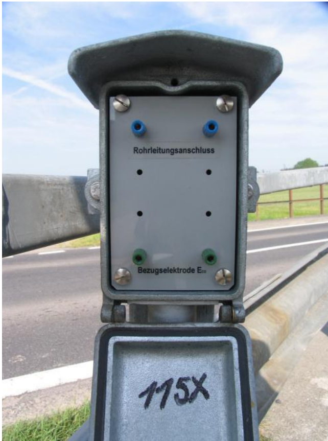
Abb. 4: KKS-Messstelle einer Rohrleitung
