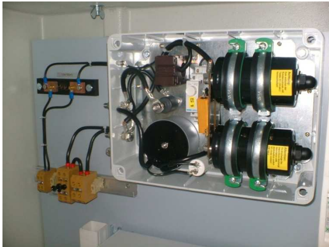
Bild: VC-Austria / Leutron....PLPro-40A, 3.Generation, mit 40A Wechselstromableitvermögen, mit Mess-Shunt
