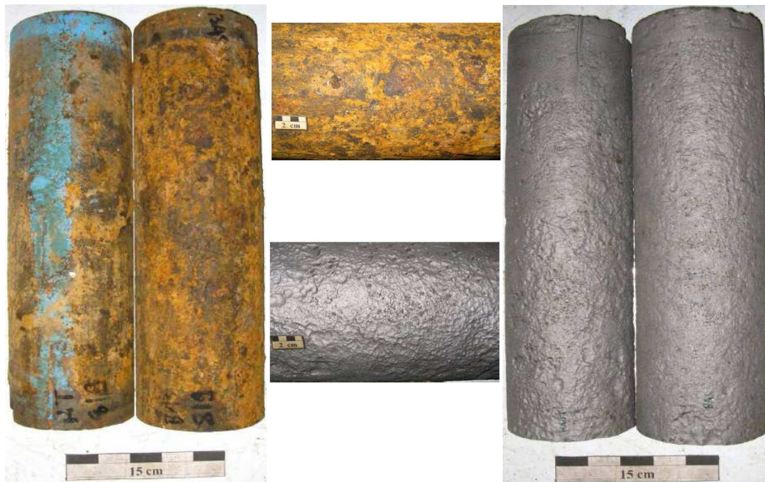
Figure 3 : Exemple d'une canalisation en fonte à graphite lamellaire avant et après sablage
