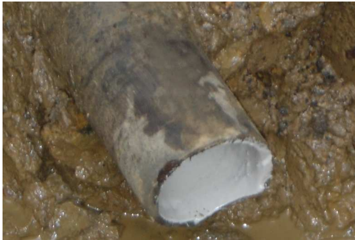
Figure 3 : Section de conduite après réhabilitation par résine époxy
