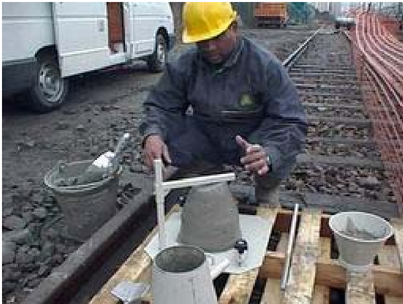
Mesures sur béton frais
