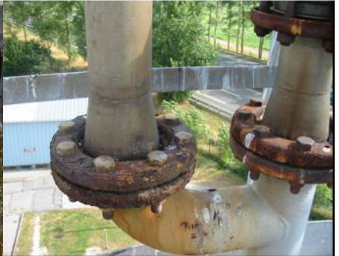
Figure 4 : Bride en ferraille sur tuyauterie inox
