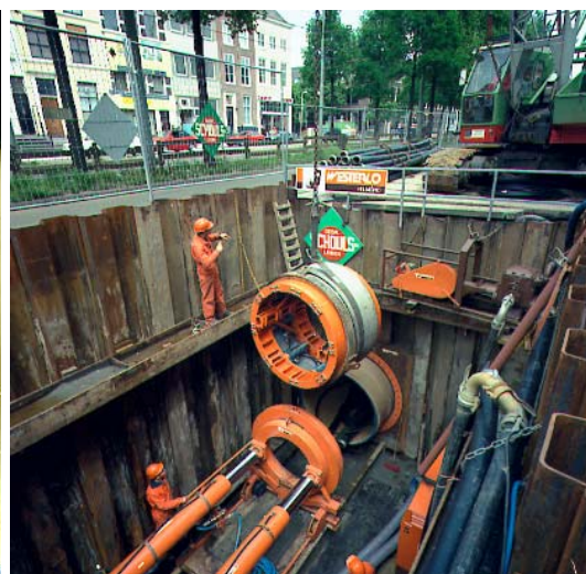
Mise en place d'une station intermédiaire
