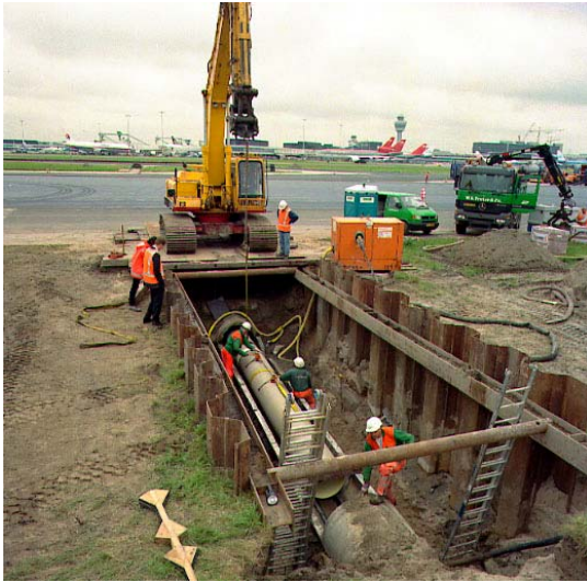
Rénovation structurante pour convoi lourd par tubage HOBAS CC-PRV en dessous des pistes de l'aéroport Schiphol
