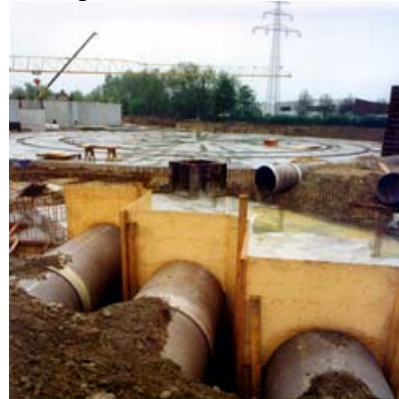
Passage des tubes entre les bassins
