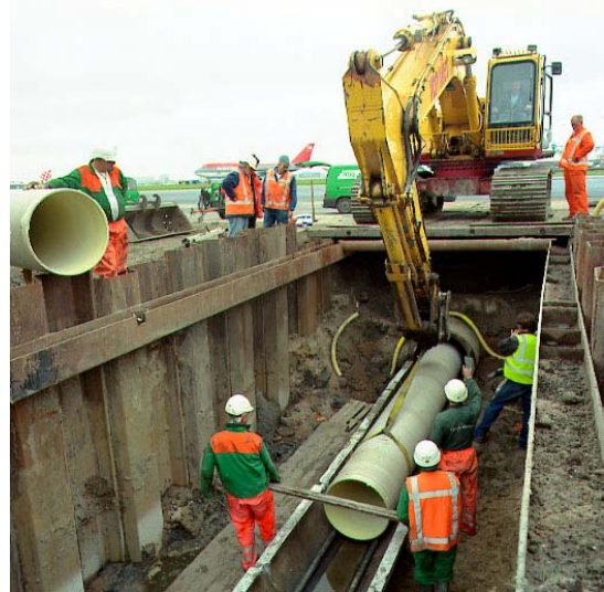
Rénovation structurante pour convoi lourd par tubage HOBAS CC-PRV en dessous des pistes de l'aéroport Schiphol
